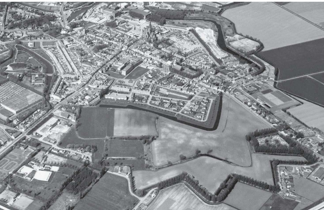
Luchtfoto waarop duidelijk de vorm van de vesting is te zien, 1974 | © archief Ad van de Par / KLM / Aeroorto
